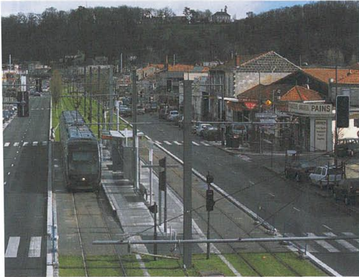
En direction des communes périphériques (Lormont et Cenon), le tramway roule sur une bande de gazon de 3 kilomètres.
