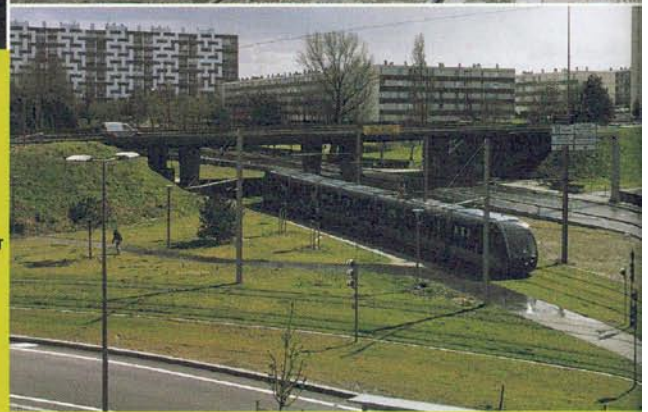
CI-CONTRE, DANS LE CENTRE-VILLE DE BORDEAUX, BANDE DE ROULEMENT EN PAVÉ DE GRANIT, ET EN PÉRIPHÉRIE, EN DIRECTION DE LORMONT, BANDE DE ROULEMENT ENGAZONNÉE.
